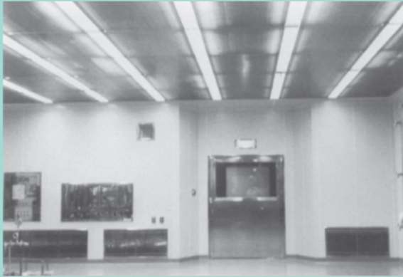
■ 築造型垂直層流方式クリーンルーム クラス100
